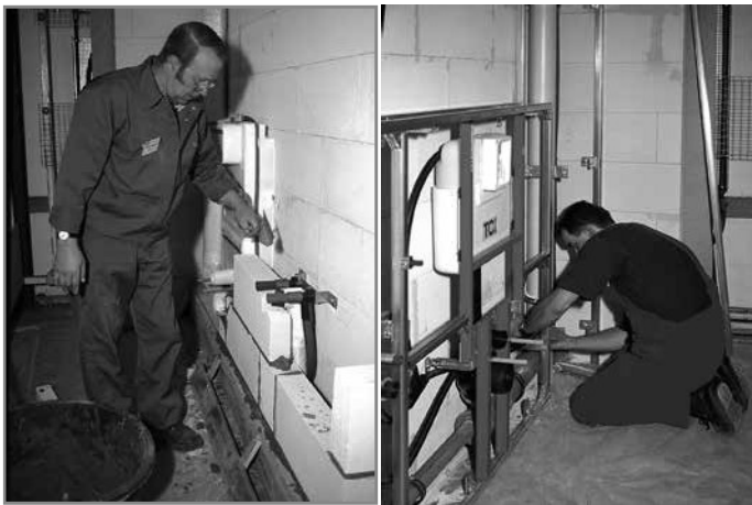
Nassbau (links) gegen Trockenbau
