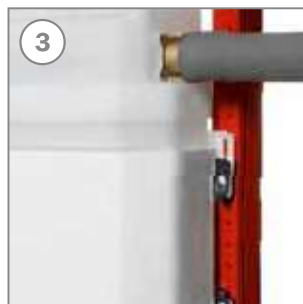
Schallentkopplung zwischen Spülkasten und Modulrahmen
