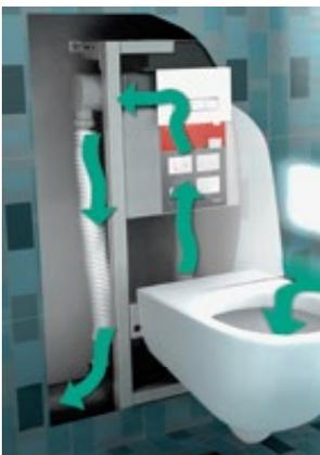
Völlig unsichtbar für den Benutzer wird die Luft durch das Abflussrohr abgeleitet. Im privaten Bereich bietet sich diese Anschlussvariante an.
